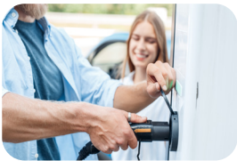
Bornes de recharge électrique
